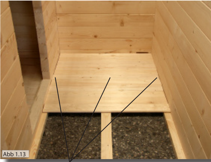
Fußboden - Schrauben 3,5 x 50 mm
