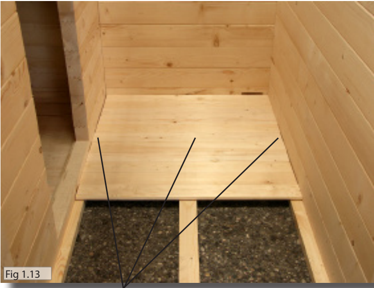
Plancher - Vis 3,5 x 50 mm
